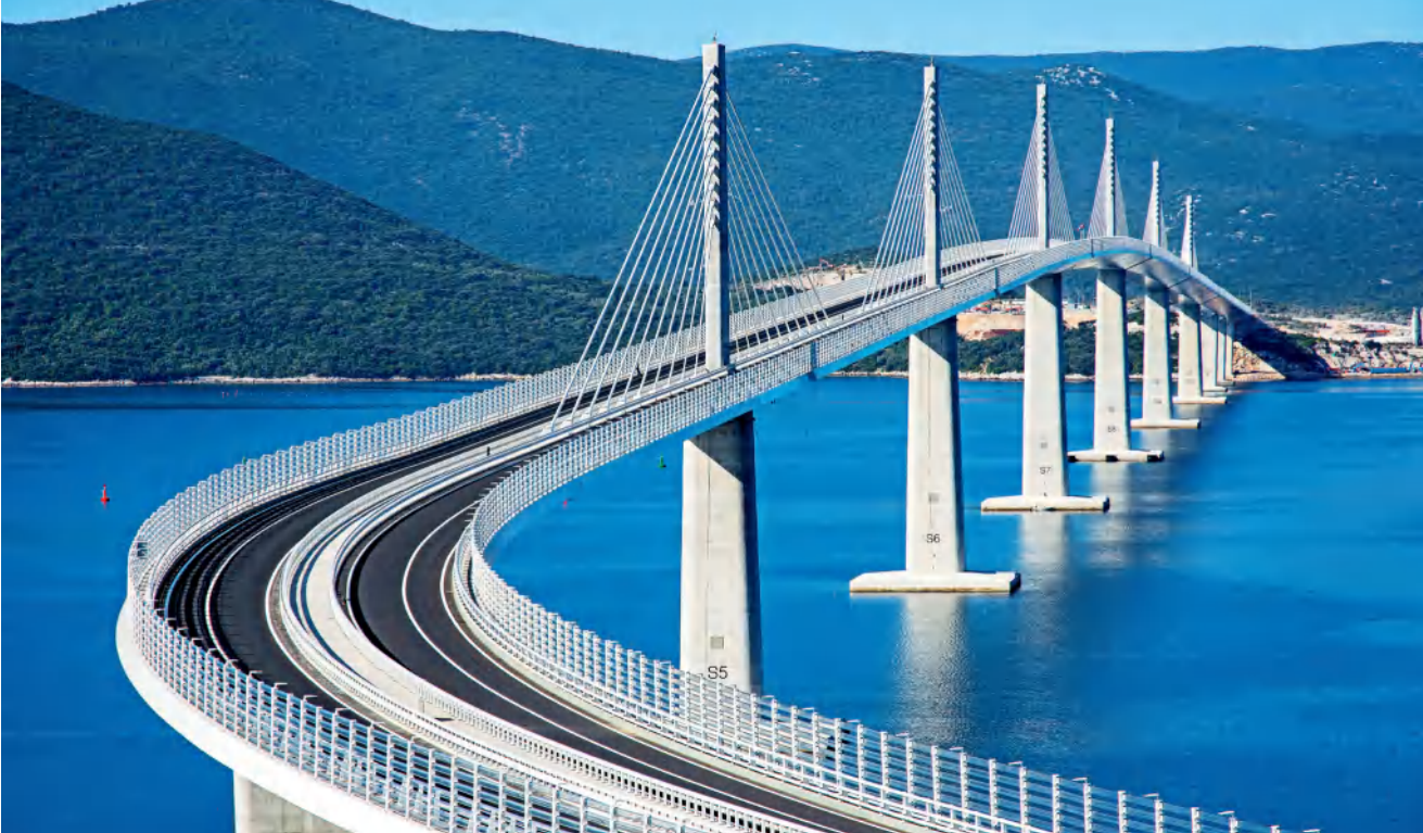
Le pont de Pelješac (Croatie), un projet phare de la coopération sino-européenne dans le cadre de l'Initiative « la Ceinture et la Route »
